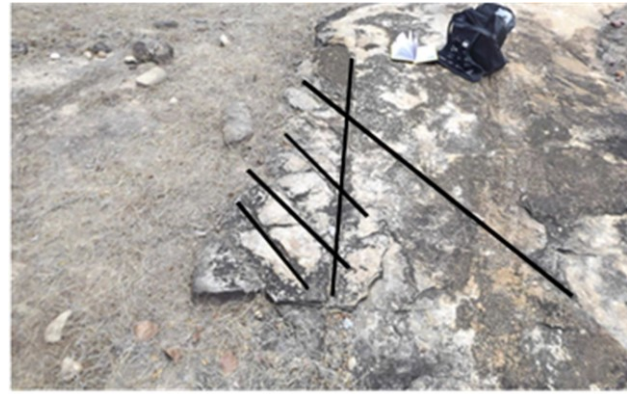
Foto 3.3 - Lajedos de granito estaca 165 - rocha maciça exibindo fraturas nas direções 300az e 270az. (E=356.750,143; N=9.528.596,482), novembro/2019.
